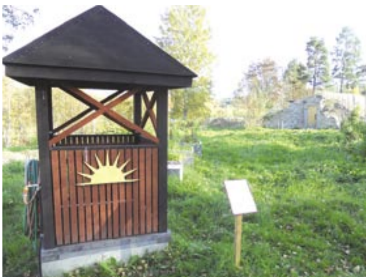
Luftbrunn och jordkällare. Från den här lilla kuren leder ett rör in i luft som förvärms till huset.
